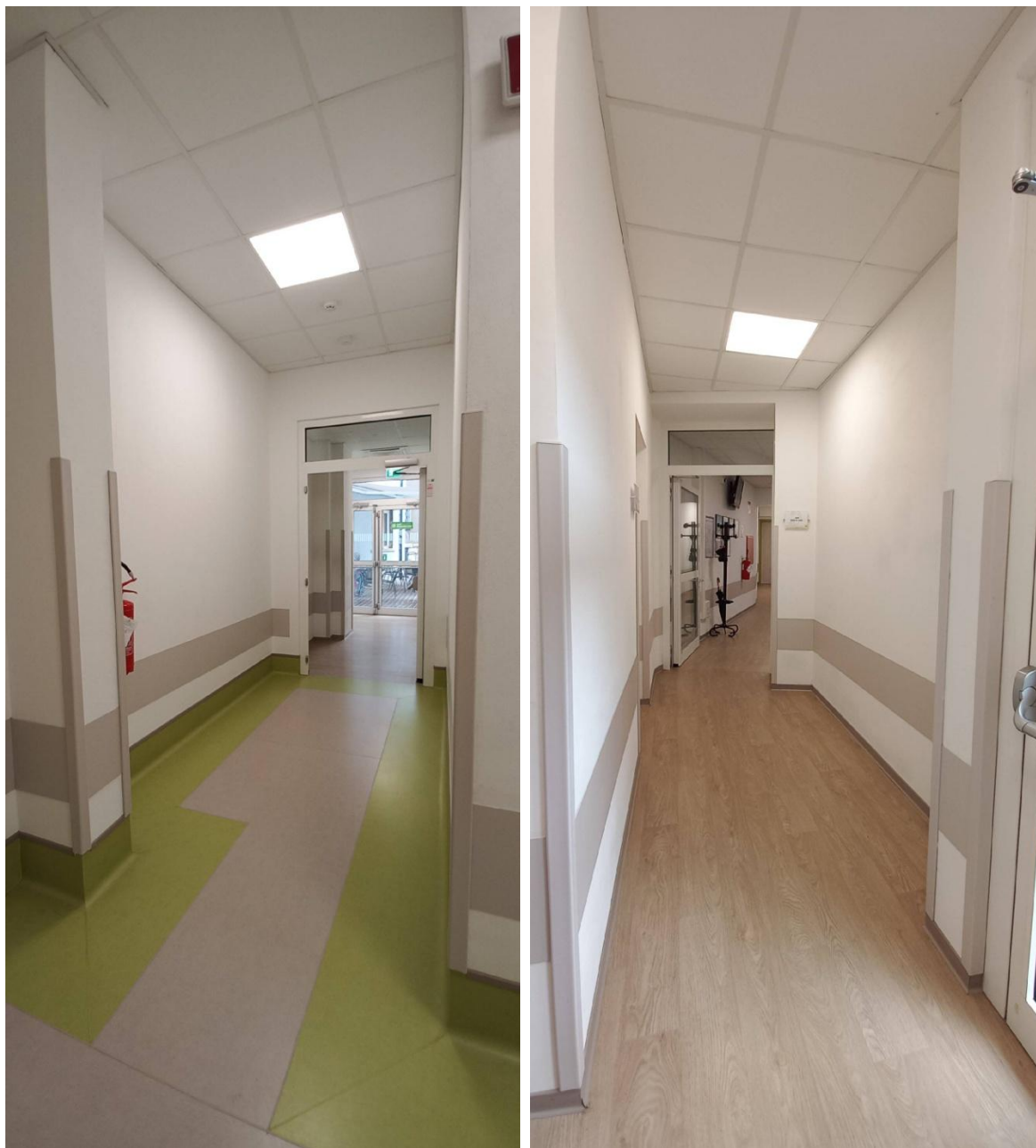
CORRIDOIO VERSO IL BAR
