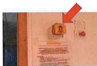
Pulsante di quench in sala magnete
