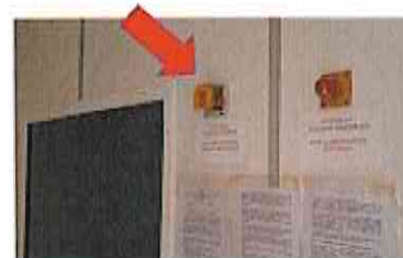
Pulsante di quench in sala magnete
