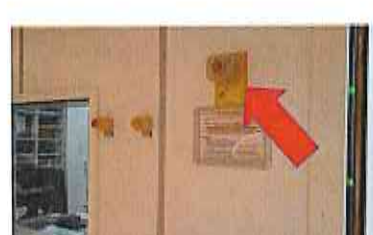
Pulsante di quench in sala magnete
