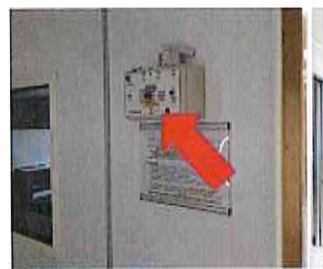
Pulsante di quench In sala magnete
