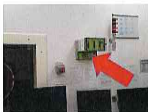
Ventilazione di emergenza in sala comandi
