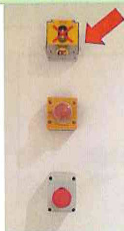
Pulsante di quench in sala magnete
